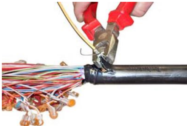
Рис. 5.Сжатие соединителя экрана с помощью плоскогубцев.
