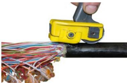
Рис. 2. Выполнение разрезов оболочки ножом KMS-K.
