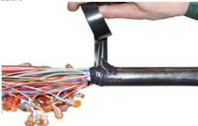
Рис. 3. Наложение бандажа под лепестком.
