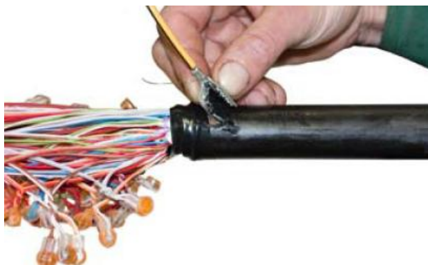
Рис. 4. Установка зажима типа «крокодил» на «лепесток».
