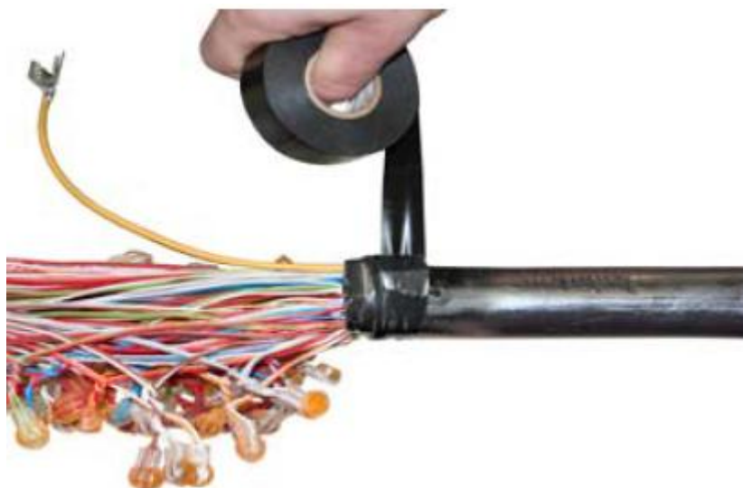
Рис. 6.Наложения бандажа на соединитель экрана и оболочку кабеля.
