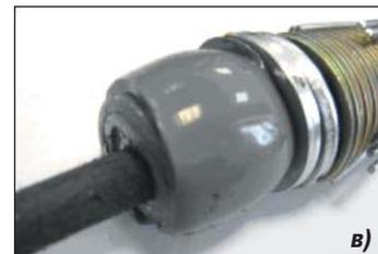
**Примечание** - Предварительно участок оболочки ОК, на который будет производиться намотка ленты мастичной (на длине около 50 мм от торца конуса), обезжирить и зачистить шкуркой шлифовальной, полиэтиленовую крошку удалить.
