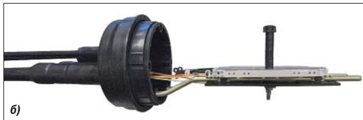
24 Надвинуть на оголовник кожух муфты, предварительно получив подтверждение измерителя о соответствии значений вносимых потерь всех сварных соединений ОБ установленным нормам.
