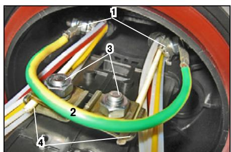
8. Закрепить ЦСЭ ОК в узлах крепления силовых элементов ОК на кронштейне между скобой и пластиной с помощью гаек.
