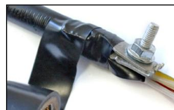
4.1. Сделать на полиэтиленовой оболочке совместно со стальной гофрированной (алюминиевой) лентой продольный разрез на длине 25 мм от ее торца, а затем – круговой на 1/2 длины окружности. Отогнуть участок оболочки вместе с лентой. Обезжирить и зачистить внутреннюю поверхность ленты под этим участком оболочки ОК.
