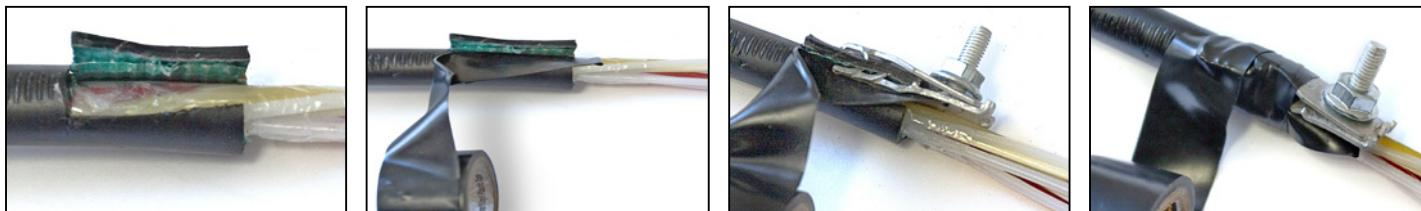
4.1. Сделать на полиэтиленовой оболочке совместно со стальной гофрированной (алюминиевой) лентой продольный разрез на длине 25 мм от ее торца, а затем – круговой на 1/2 длины окружности. Отогнуть участок оболочки вместе с лентой. Обезжирить и зачистить внутреннюю поверхность ленты под этим участком оболочки ОК.
