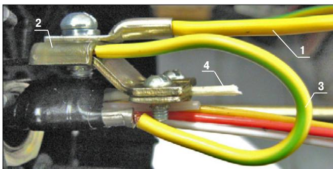
1 – перемычка электрического соединения вводимых ОК;
