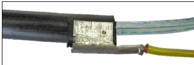
3. Подключить перемычку, соединенную с алюмополиэтиленовой оболочкой, к кронштейну кабельного ввода. Освободить от изоляции конец провод перемычки на длине 20 мм, загнуть оголенную жилу в виде полулучти и завести под скобу. Закрепить перемычку на кронштейне с помощью скобы, пользуясь отверткой.
